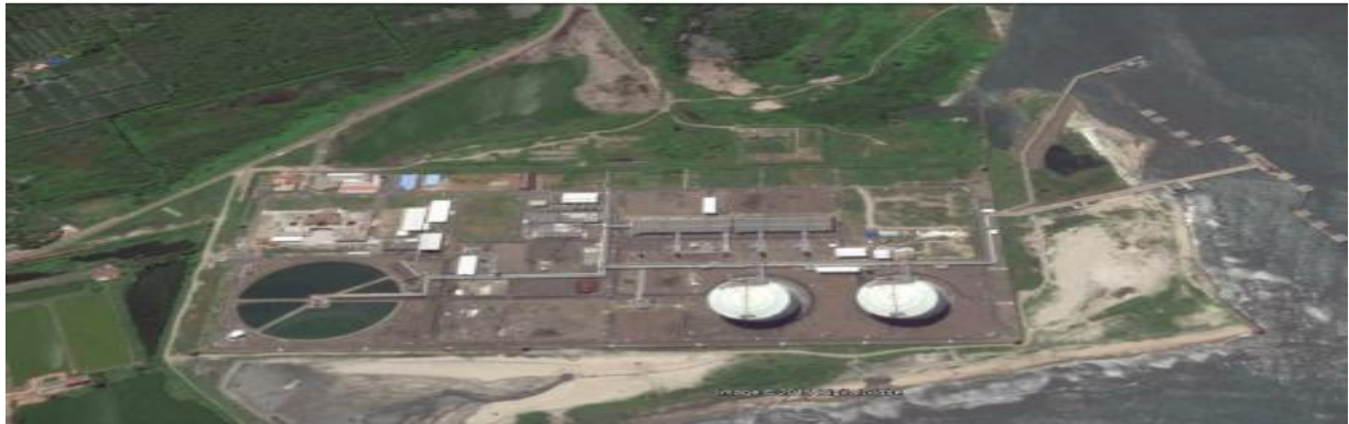
Fig 4.4 Kochi LNG Terminal Source: Google Earth
